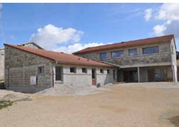
La construction d'une MSP à Pierrefitte-sur-Aire (Meuse). D.R.
